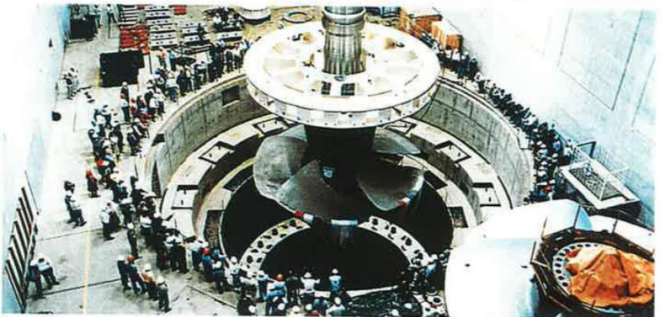
Laufradmontage im Kraftwerk.
